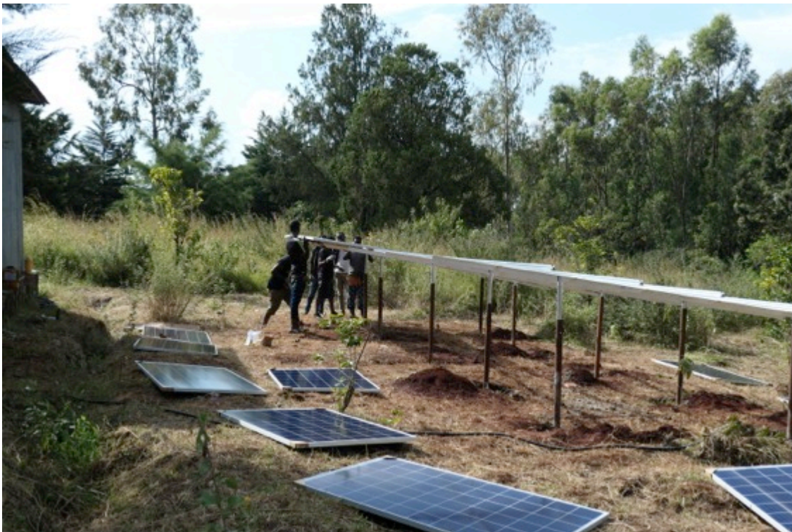
Montage der Module auf dem Grundgestell
