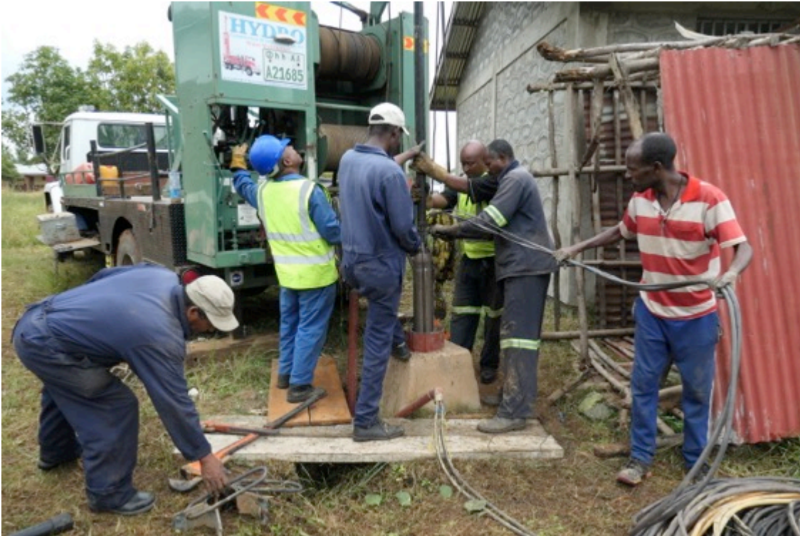
Ausbringung der Pumpe aus dem Bohrloch
