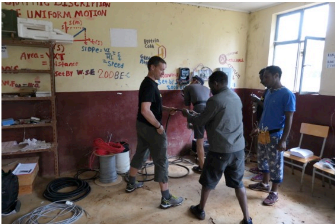
Verkabeln und anschliessen
